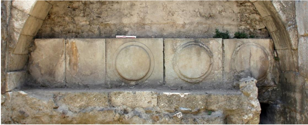
Fig.32: Batı Portiko batı galeride konumlanan sarnıcın kuzey cephesi.
