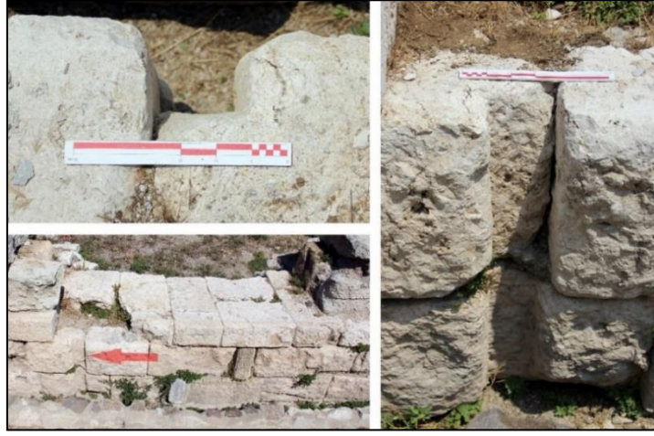
Fig.27: Batı Cephe drenaj oluğunun konumu ve cepheden ve üstten görünümü.
