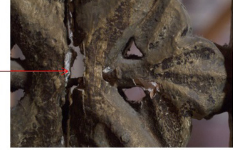
Resim 41, 7 Nolu Şebeke (7.3), çivi ile tespit.
