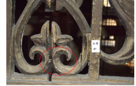
Resim 43, 4 Nolu Şebeke (4.7), çivi ile tespit.
