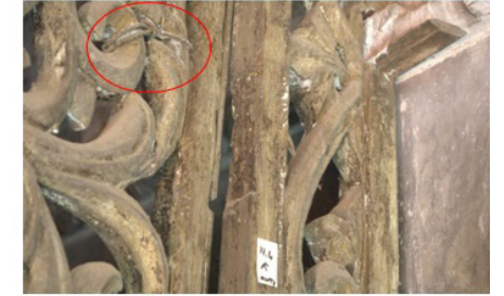
Resim 45, 11 Nolu Şebeke (11.4), kapı, tel ile tespit.
