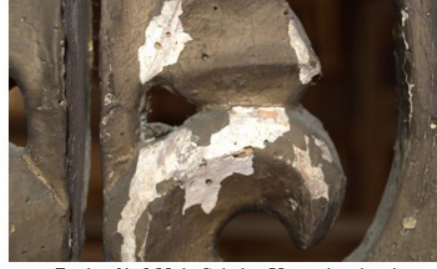
Resim 61, 2 Nolu Şebeke, Yüzeyden Ayrılma.
