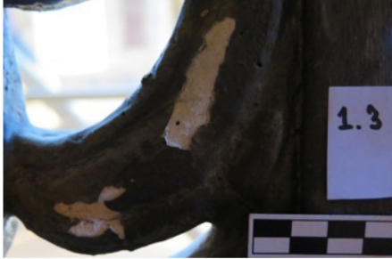
Resim 62, 1 Nolu Şebeke (1.3), Yüzeyden Ayrılma.
