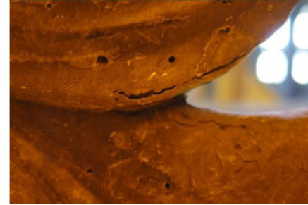
Resim 63, 2 Nolu Şebeke, yüzeyden Ayrılma.
