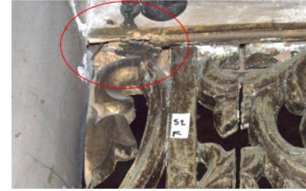
Resim 44, 5 Nolu Şebeke (5.2), çivi ile tespit.
