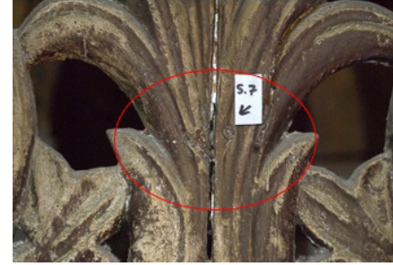
Resim 42, 5 Nolu Şebeke (5.7), çivi ile tespit.
