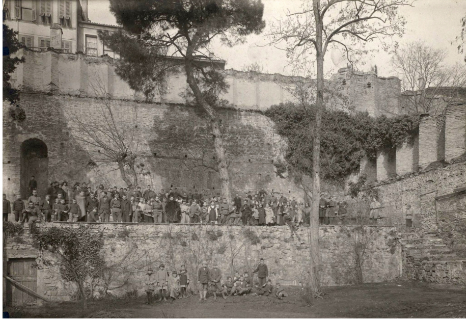
Şekil 6: Tophane'de hamam kalıntılarının olduğu teraslar ve istinat duvarları.
