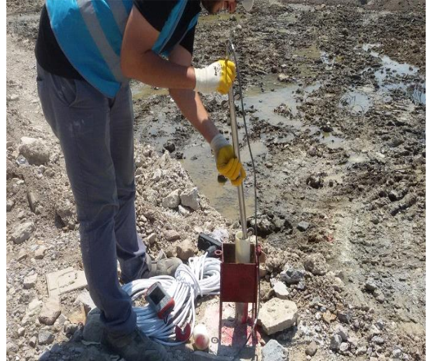
Şekil 3. İnklinometre borusunun yerleştirilmesi
