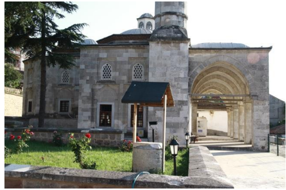
Resim 10. Beylerbeyi Camii'nin Kuzeydoğu Cephesi (07.06.2019).
