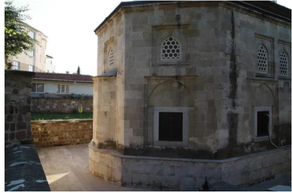
Resim 11. Beylerbeyi Camii'nin Kuzeydoğu Cephesi (07.06.2019).
