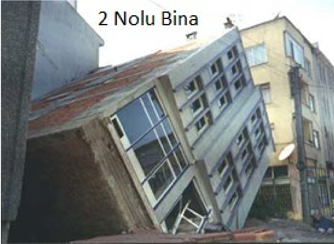
Şekil 5. Devrilen 2 Nolu Bina (Yükseklik:13.50 m, Genişlik:7.50 m), [1] (Overturned Building #2 (Height:13.50 m, Width:7.50 m))
