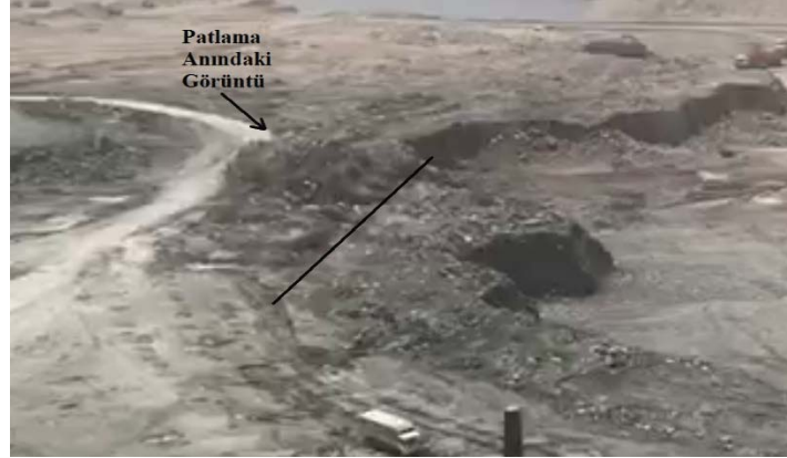
Şekil 5. İkinci patlatma bölgesi, patlatılma anındaki durum
