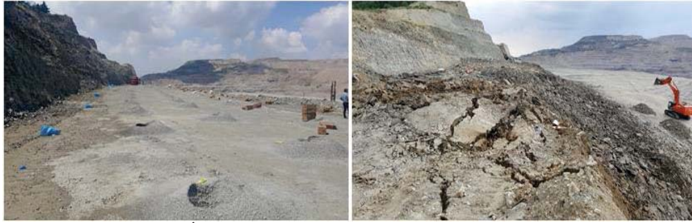
Şekil 3. İlk patlatma uygulaması öncesi ve sonrası görünüm
