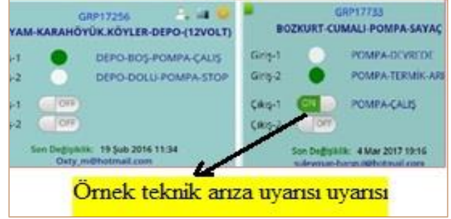
Şekil 7: Pompa kontrol akıllı sistemi önyüzü.
