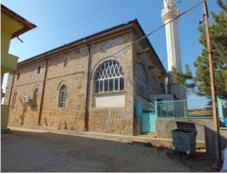
Fotoğraf 1. Ilgın, Balkı Köyü Camii genel görünüm
