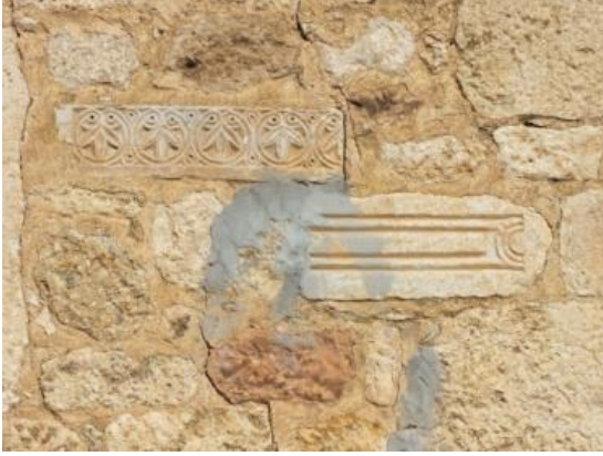
Fotoğraf 2. Güney cephede yer alan devşirme malzemeler
