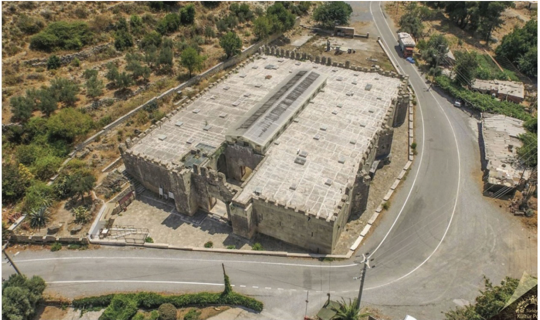
Resim 10: Alara Han'ın havadan görünüşü ( https://www.kulturportali.gov.tr )
