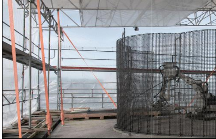
Şekil 9. 3D baskı robotik yazıcı ile donatı teşkili.
