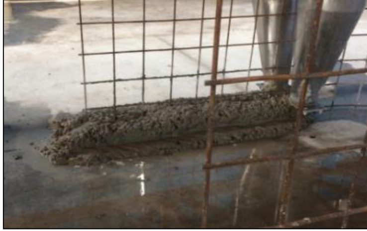
Şekil 8. 3D baskı yazıcı ile üretimde donatı çubuklarının yerleştirilmesi.
