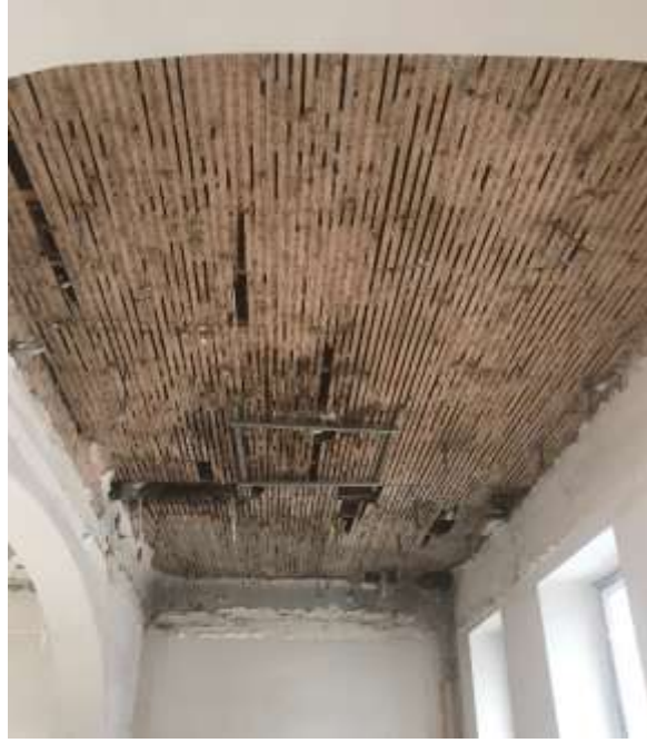
Resim 2: Zemin katın ahşap tavan kaplaması
