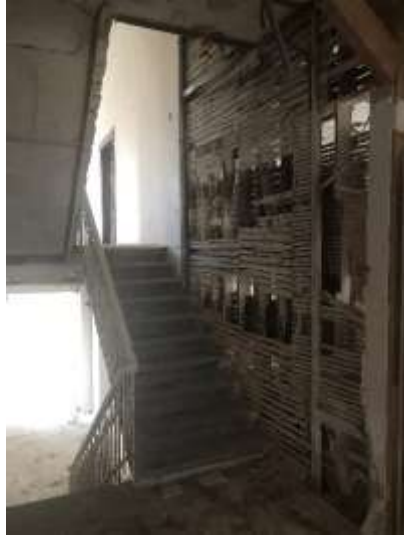
Resim3: Birinci katta yer alan ahşap çıtalı ara duvarlar
