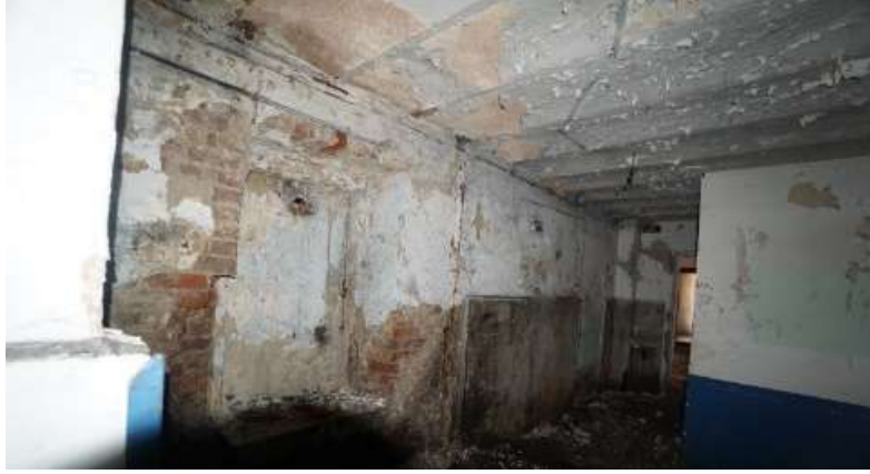
Resim 1: Bodrum katın kağır duvarları
