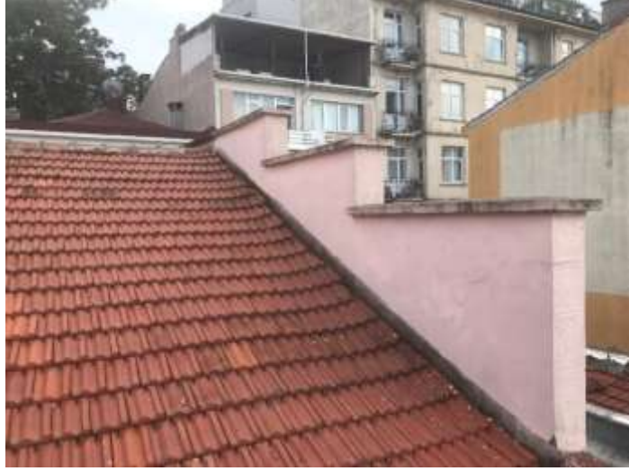
Resim 6: Kademeli çatı parapetleri
