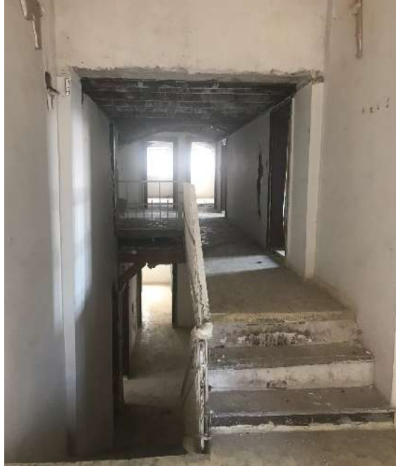
Resim 4: Çatı katına çıkan merdivenler ve çatı katı holü
