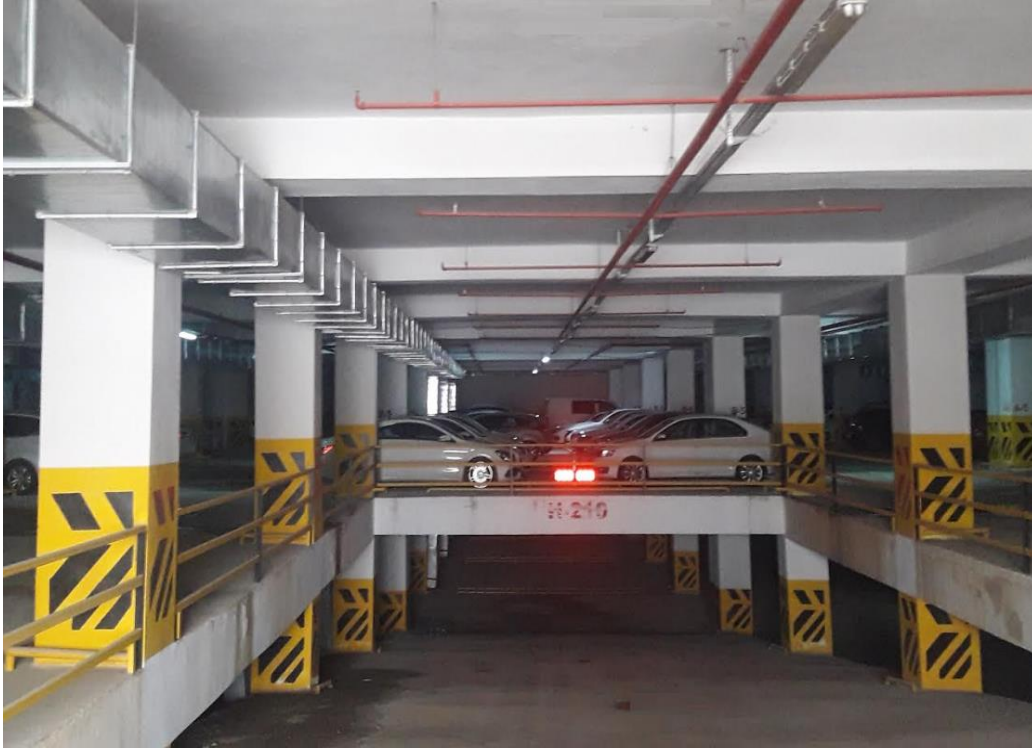
Şekil 1. Kapalı otoparkın girişten görünüşü
