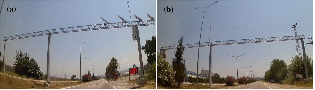
Şekil 6. 3 numaralı koridora ait (a) giriş ve (b) çıkış için koridor hızı ihlal tespit sistemi.
