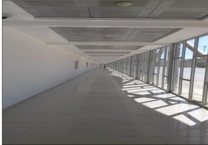
Fotoğraf 2. Modernizasyon Sonrasında Esendere Sınır Kapısı Cam Koridor Geçiş Alanı
