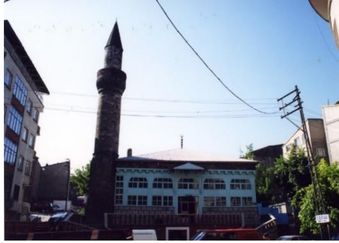
Fotoğraf No 3: Restorasyondan Önce Kuzey Cephe (VBM Arşivi)
