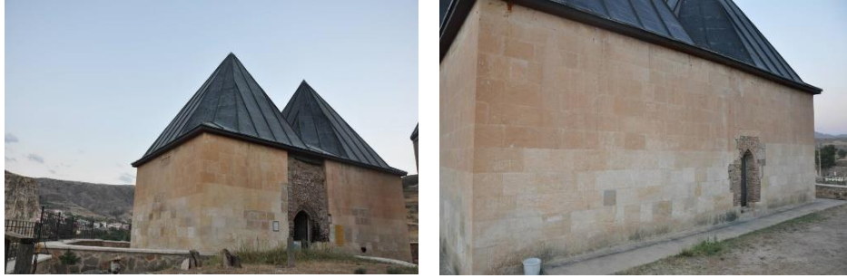
Foto. 3: Behramşah Türbesi (Zaviyesi), Kuzey ve Güney Cepheleer
