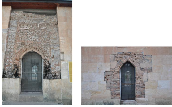
Foto.4: Behramşah Türbesi (Zaviyesi), Güney ve kuzey Cephe Giriş Açıklıkları
