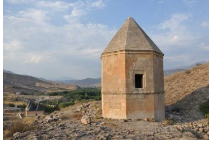
Foto. 8: : Gözcü Baba Kümbeti, Güney Cephe
