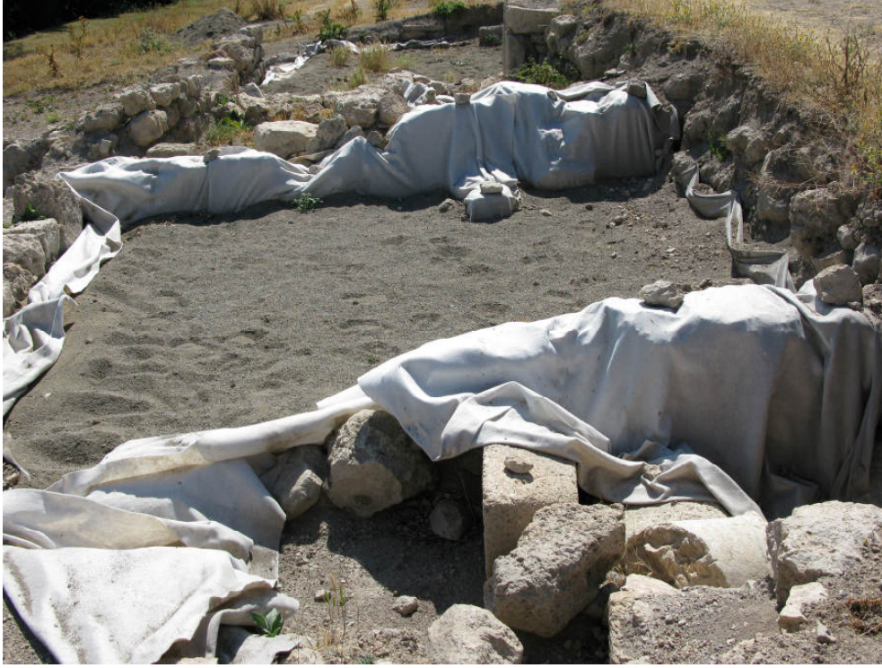
Fig. 9 Üzeri geotekstil ve ince bir kum tabakası örtülerek, dönemsel olarak koruma altına alınmış, periyodik kontrol ve bakımı gerektiren, taban mozaïği
