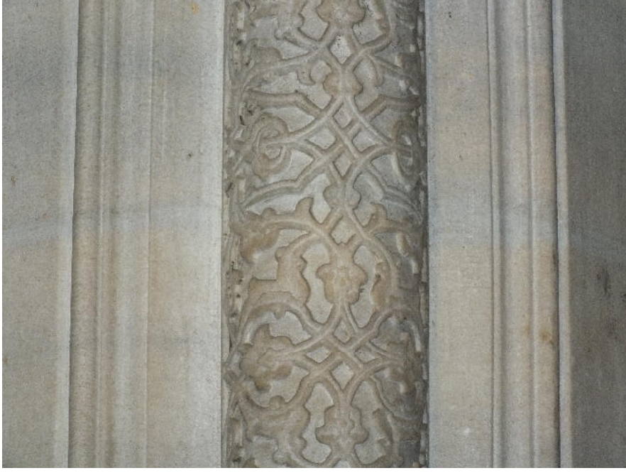
Fig. 7 Kapı köşe sütuncesi
