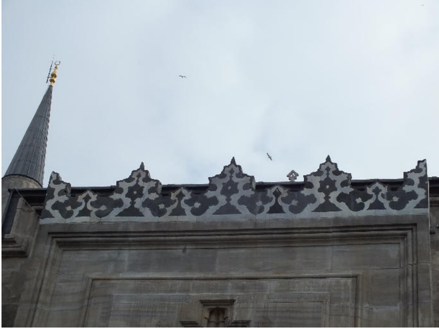
Fig. 8 Avlu kapısı tepeliği.
