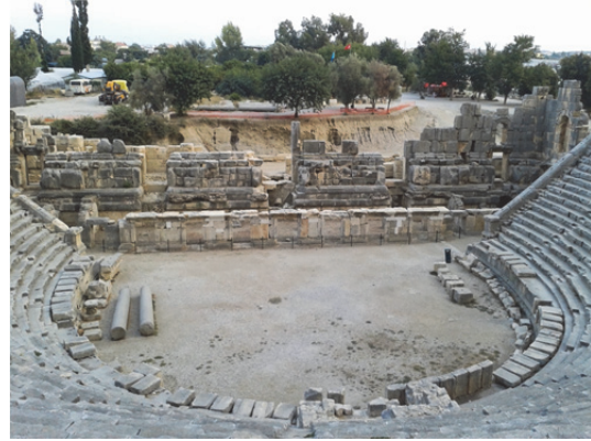
Fig. 13. Myra Tiyatrosu Restorasyonu
