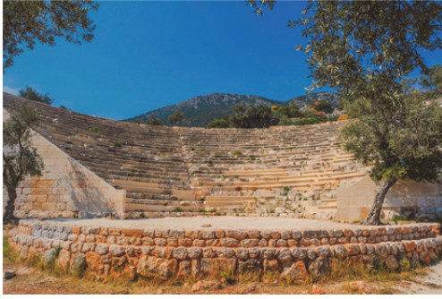
Fig. 11. Antiphellos Tiyatrosu Restorasyonu
