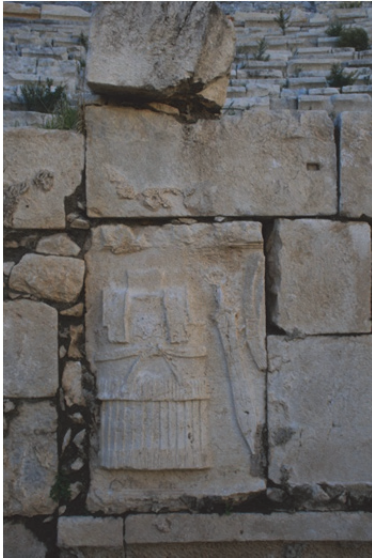
Fig. 63. Patara Tiyatrosu Devşirme Lorica Kabartmalı Parapet Duvarı
