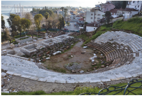
Fig. 12. Telmessos Tiyatrosu Restorasyonu
