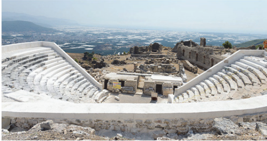
Fig. 10. Rhodiapolis Tiyatrosu Restorasyonu
