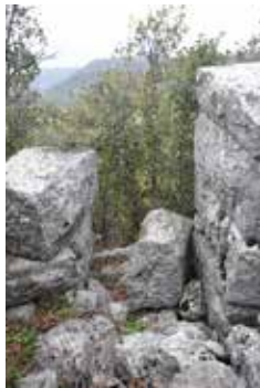
Abb. 39. Tor in der südlichen Burgmauer, Innenansicht von Norden
