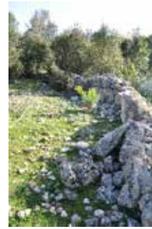
Abb. 68. Blick auf kreisförmigen Mauerzug von Norden
