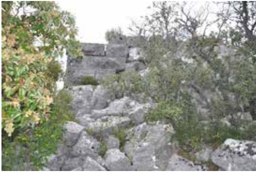
Abb. 33. Burg, Nordwestturm von Westen
