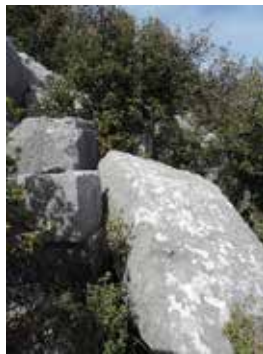
Abb. 42. Nordwand des Podiumbaus
