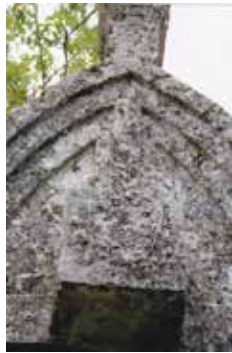
Abb. 74, 1. Giebel mit Öffnung unter der kranzverzierten Hebebosse
