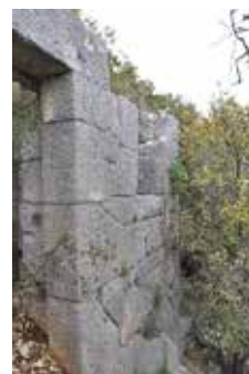
Abb. 49, 2. Gebäude am Südhang des Burgberges mit Eingang von Südweste
