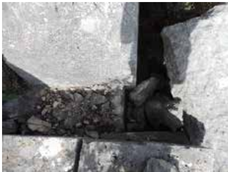
Abb. 47. resalitartiges Ende der westlichen Seitenwand von Osten, Detail
