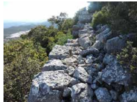
Abb. 38. Burg, Aufsicht der Südmauer von Osten
