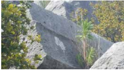
Abb. 45, 2. Der monolithische Block und Südmauer des Podiumsbaus von Südosten
