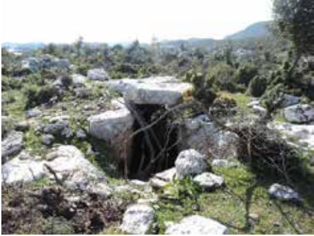
Abb. 93. Zisterne im Westen der Anlage mit der Kirche
