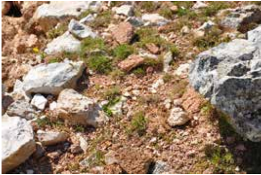
Abb. 86. Hydriolische Mörtelresten im Hauptraum
