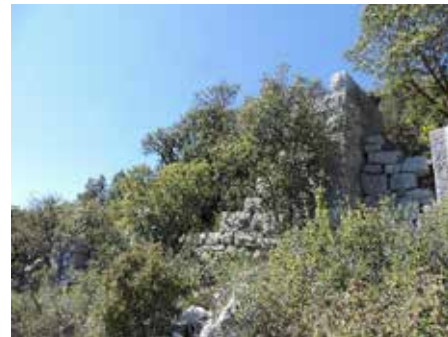
Abb. 48. Gebäude am Südwesthang des Burgberges von Süden
