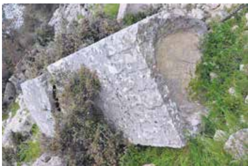
Abb. 8. Das ausgehöhlte Oberlager des Pfeilerschaftes stand 2015
