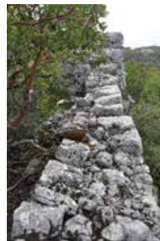
Abb. 36. Burg, Aufsicht der Nordmauer mit Nordwestturm von Osten
