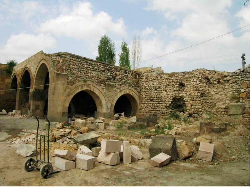
Foto 8: Avlu Kuzey Kanat (Onarım Öncesi)
