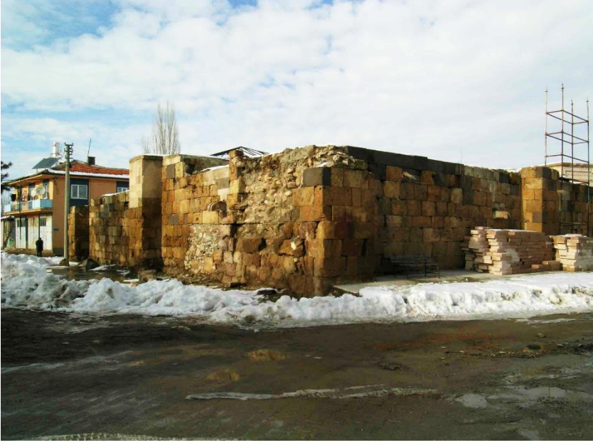
Foto 5: İshaklı Sâhib Ata Kervansarayı, Batı Cephe (Onarım Öncesi)
