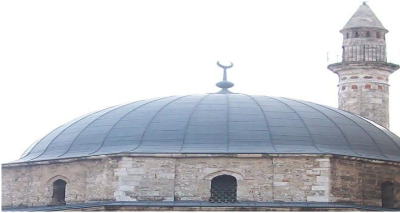
Resim 2. Câmînin Kubbe ve Minaresi (Şahin, 2013).
