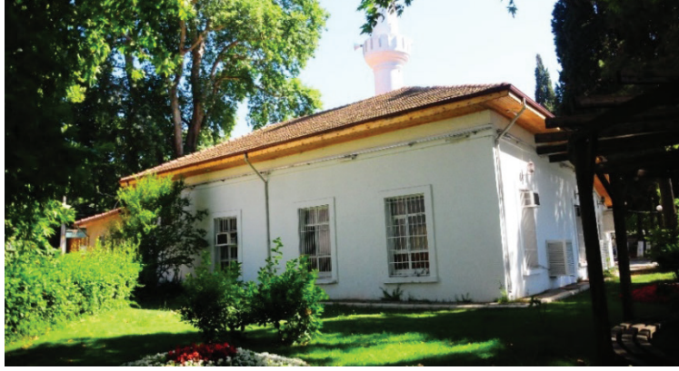
Resim 7: Hereke Fabrika-i Hümâyûn Camii Güneybatı Cephesi (Günümüz Durumu)
