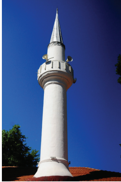
Resim 8: Hereke Fabrika-i Hümâyûn Camii Minaresi (Günümüz Durumu)
