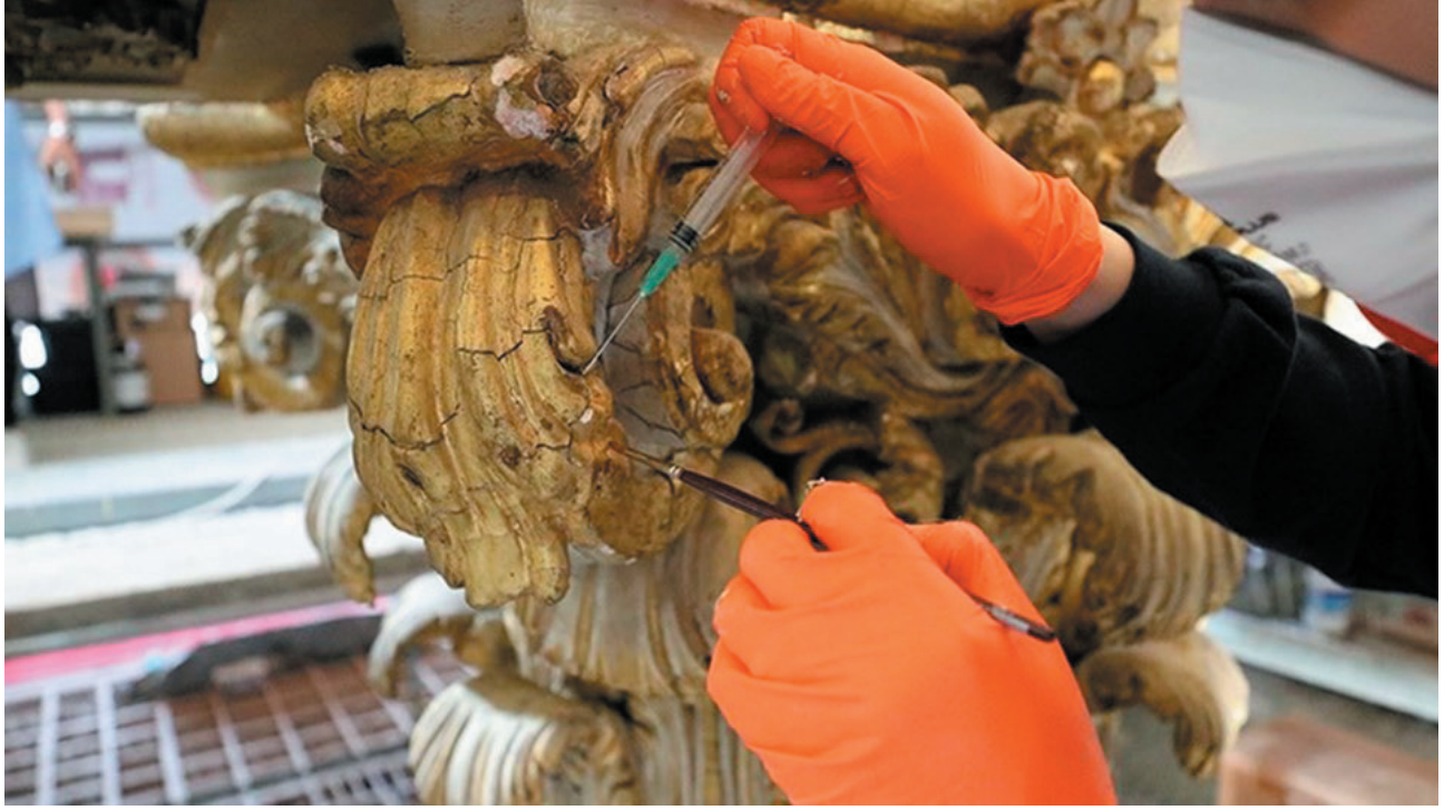
4.1.3 Yüzeiden kalkan parçaları yapıştırma
