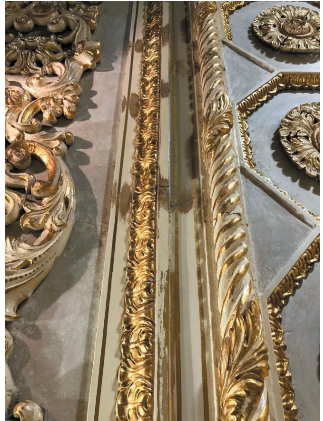
4.1.2 Raspa uygulama sonrası
