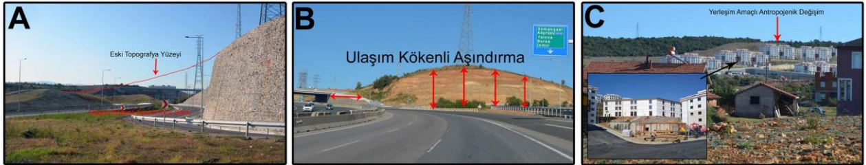
Fotoğraf 6: A) ve B) D-100, Tem ve Kuzey Marmara Otoyolu Bağlantısı İçin Rolyefin Değiştirilmesi, C) Dilovası Köşeler Mahallesi Yeni Yerleşim Amacıyla Rolyefin Düzenlenmesi
