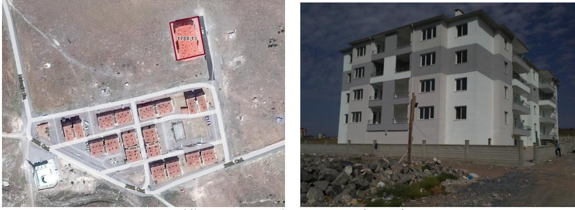
Şekil 1. Yapının arazi görünümü ve fotoğrafı
