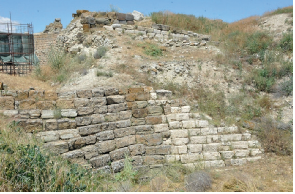
Resim 13. Gordion'daki destek duvarı.
