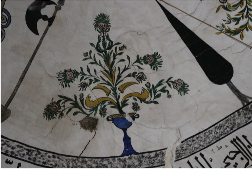
G. 16. Banaz Yeşilyurt Köyü camii, bağdadi kubbe, ayrıntı (Şeyda Algaç, 2019)
