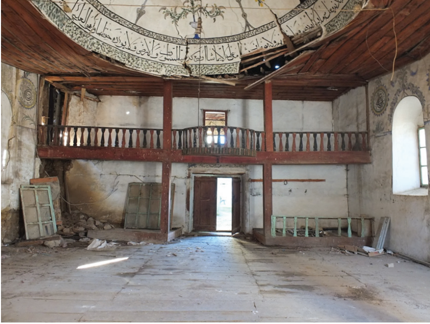
G. 12. Banaz Yeşilyurt Köyü Camii, kuzey duvarı (Şeyda Algaç, 2019)
