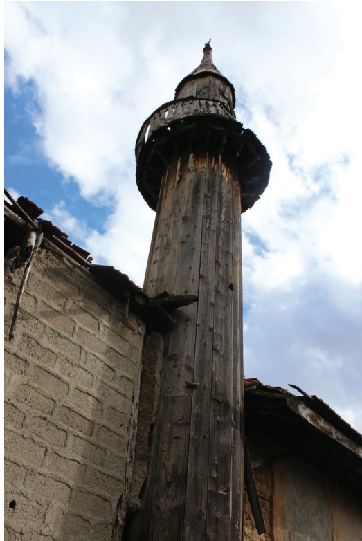
G. 4. Banaz Yeşilyurt Köyü Camii, ahşap minare (Şeyda Algaç, 2019)
