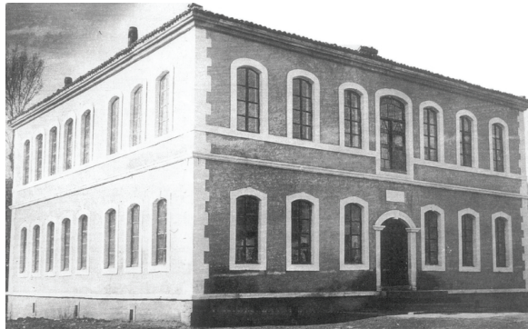
G. 9. Ertuğrul Mektebi Güney ve Doğu (Arka) Cephe Genel Görünüşü (A. Demiröz, 2001).
