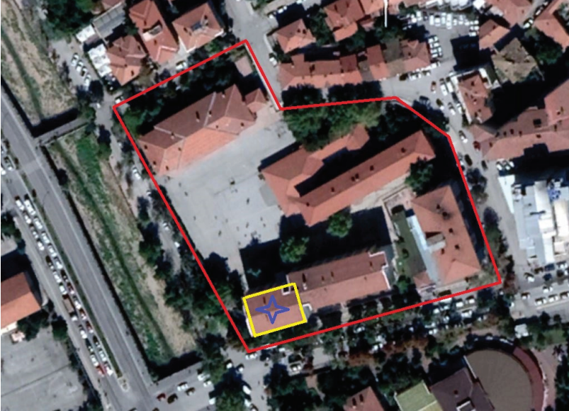
G. 3. Yıkılan Ertuğrul Mektebi'nin Bulunduğu Alanın Güncel Uydu Görünümü (40.36200 K, 33.364827 D Google Earth Pro Uygulamasından).
