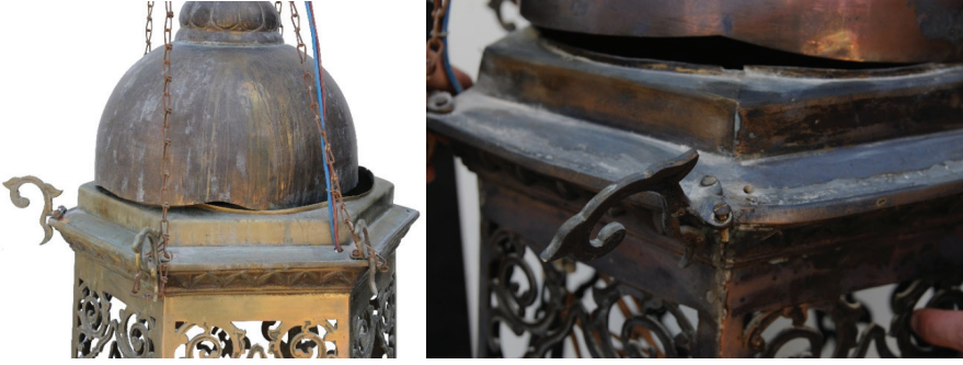
G. 15. Altıgen fenerlerde hasar durumu; a) biçimsel bozulma ve yüzeylerdeki korozyon oluşumu (solda), b) yerinden çıkmış köşebent kancası (sağda) (M. Sağır, 2015)
