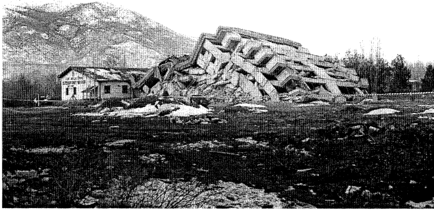
Resim-1. Konut Yapı Kooperatifi inşaatından hasar görüntüsü.
