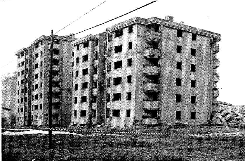
Resim-2. Konut Yapı Kooperatifi inşaatından hasar görüntüsü.. 3 katı yerine çökmüş bir bina...
