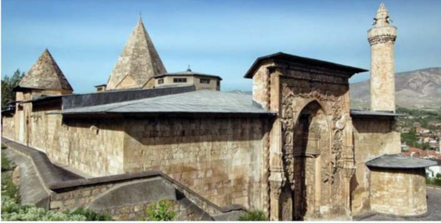
Fotoğraf 5. Divriği Ulu Camii Darüşşifası, kuzey ve doğu cepheden görünüm, Türbe.
