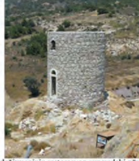
Yel değirmeninin restorasyon sırasındaki görünümü
