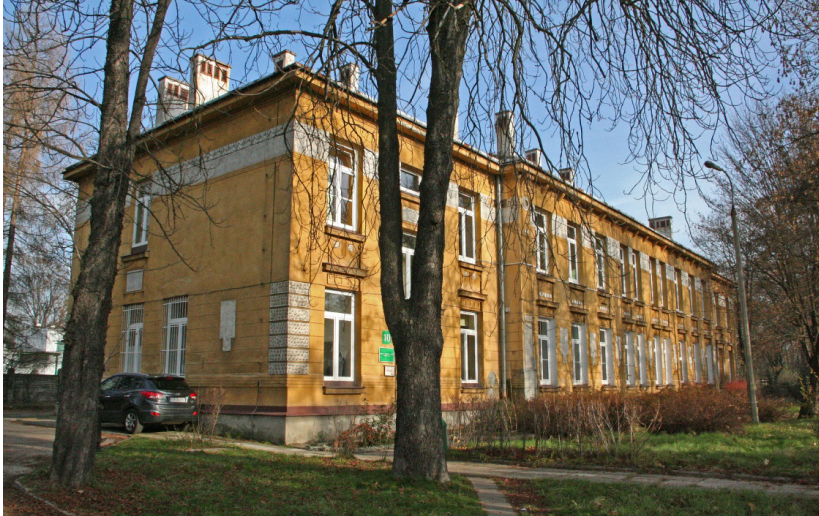
3. Krakow Wroclawska Caddesi 1-3 adresinde bulunan 5. Askeri Hastane Polikliniđi (eski Garnizon Hastanesi No: 15) Verem ve Akciđer Hastahkları binası. Veremden ölen Ahmetođlu Ahmet, İsmail Hasan Onb., Ali Osman Plut. ile Yusuf Şaban Bekir hayatlarına bu binada veda etmişler. (Fotoğraf: Piotr Nykiel)
