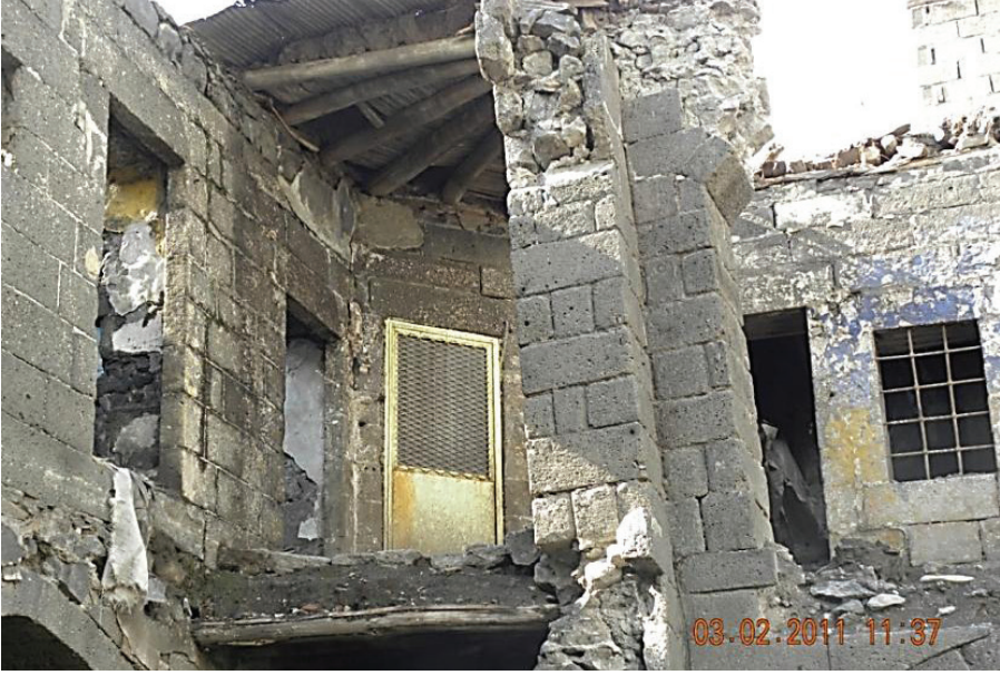
Foto. 18: Çifte Han Revak Örtü Sistemi Detayı.
