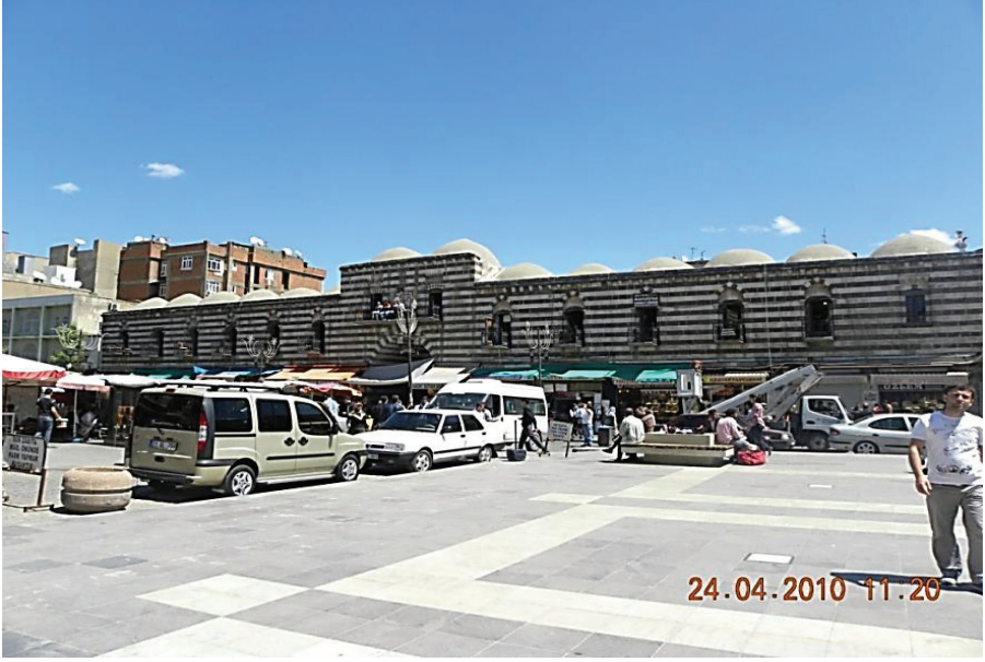
Foto. 8: Hasan Paşa Hamı Genel Görünüşü.
