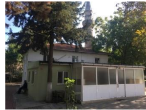
Foto. 3: Rüstem Paşa Camii, genel görünüm.
