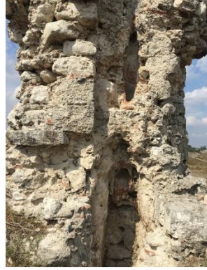
Foto. 12: 1 nolu su terazisinden detay.
