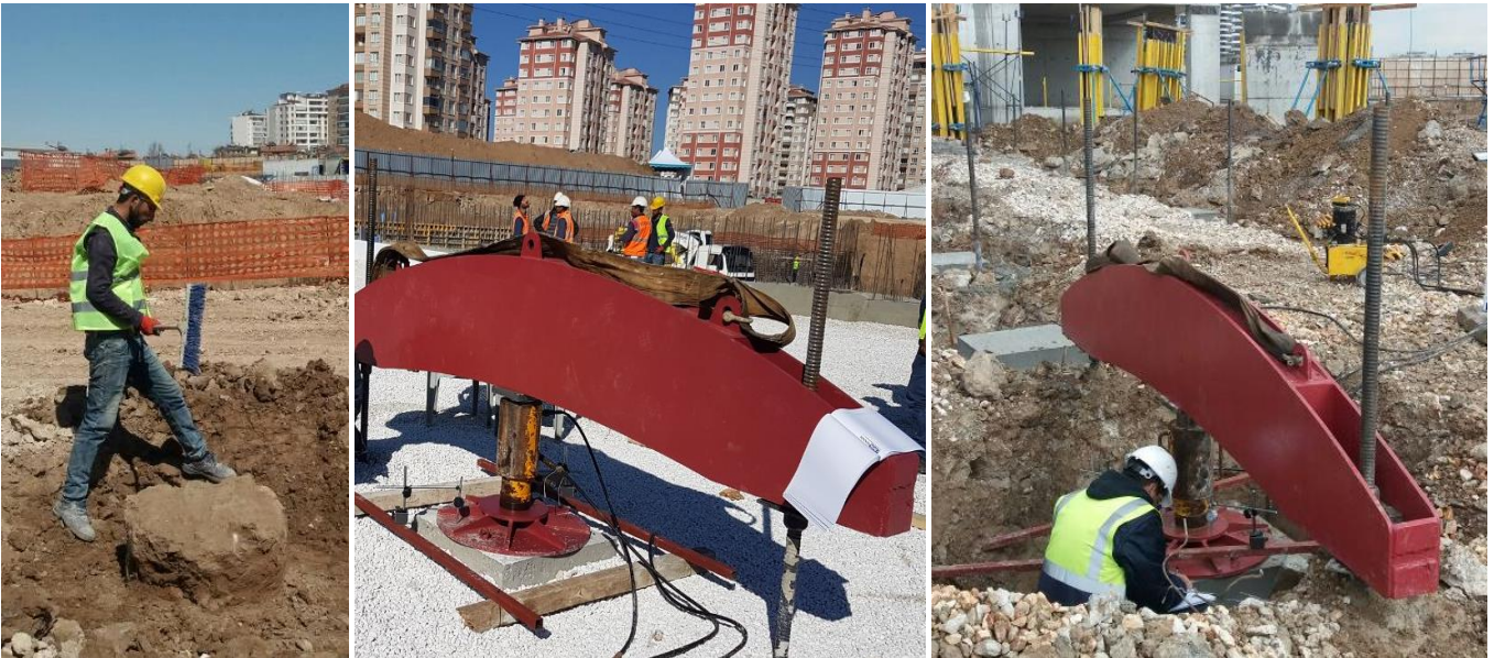
Şekil 3. a) Kolon Bařlarının Aılması, b) Jet-Grout Yükleme Düzenegi, c) Jet-Grout Kolonu Yüklenmesi Ve Veri Alınması
