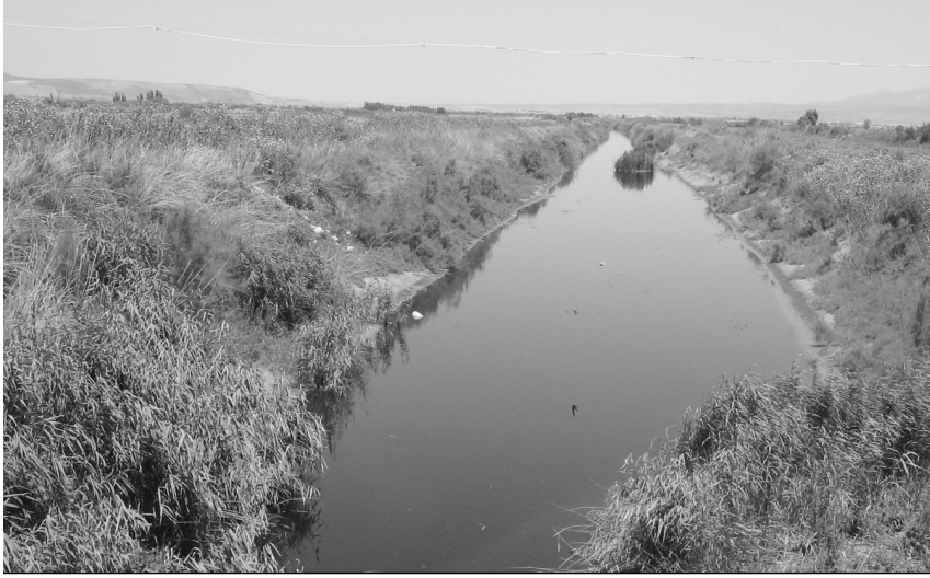
Cellât Gölü'nün kurutulması için açılan kanalın günümüzdeki durumu
