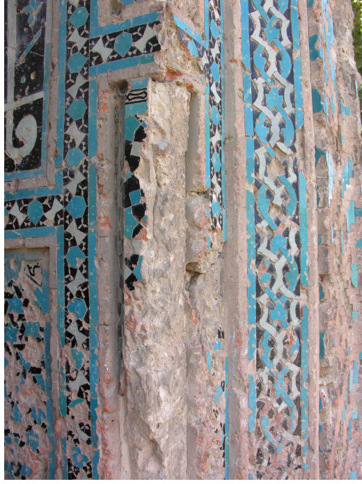
Resim 21. Berde Trbesi. Kuzey takapı ana niş kşe stuncesindeki ini mozaik ssleme.
