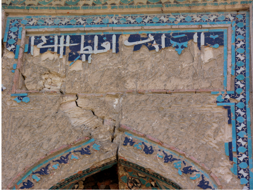
Resim 2. Berde Türbesi: Kuzey taçkapı üzerindeki usta kitabesi
