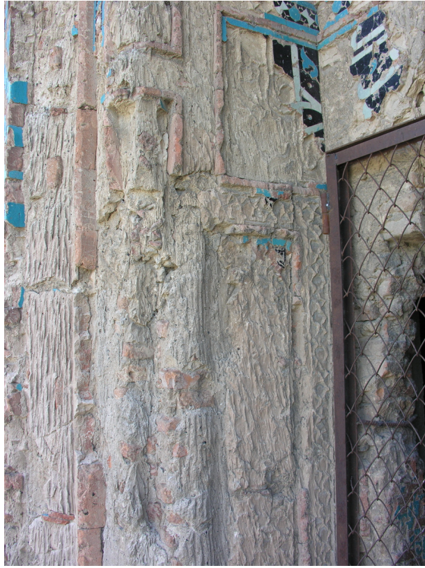
Resim 18. Berde Türbesi. Kuzey taçkapı ana niş sol yan duvarındaki mihrabiye.
