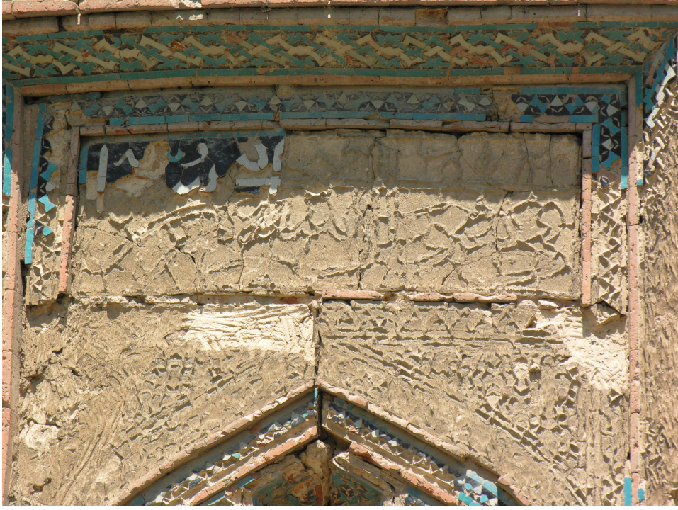
Resim 3. Berde Türbesi: Güney taçkapı üzerindeki inşa kitabesi
