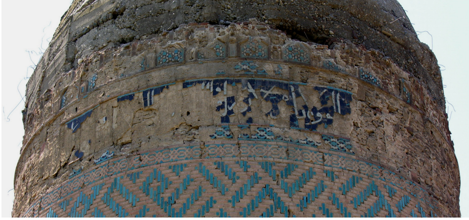
Resim 9. Berde Türbesi. Saçak altı kitabe ve süsleme kuşakları.
