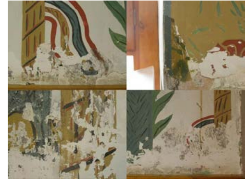
Resim 15. Resim Yüzeylerindeki Boya Dökülmesi Örnekleri (E. Yetiş, 2015).
