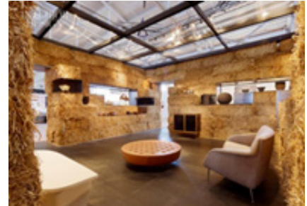
Görsel 2. Samanın yapı malzemesi olarak kullanımıyla oluşturulmuş bir konut (Eser, 2016)
