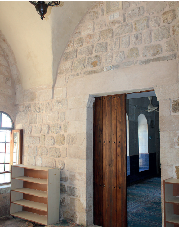
Resim 15 Şeyh Şeyhullah Camii. Giriş Mekânı (Selsebilli Eyvan). Güney Cephe Düzenlemesi, 2016.
