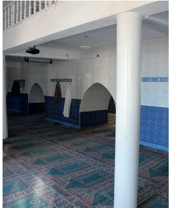
Resim 19 Şeyh Şeyhullah Camii. Harim Giriş Kapısı, 2016.
