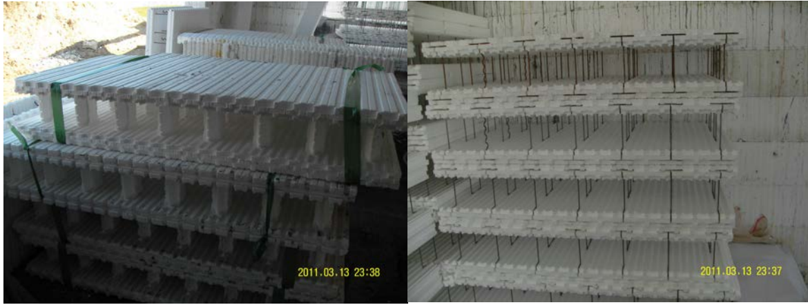
Şekil 2. Mâliyet Hesabında Kullanılan EPS ve Metal (Tel) Bağlantı Köprülü EPS Kalıplar [1,5]
