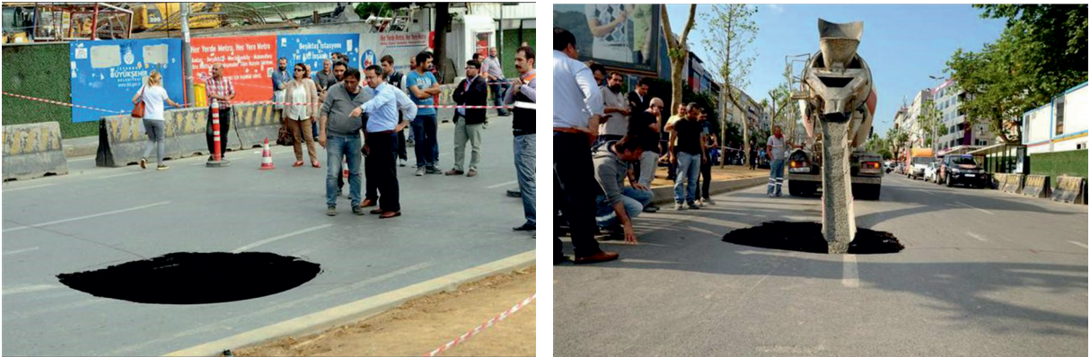
Şekil 8. Beşiktaş Barbaros Bulvarı'nda (Kabataş-Mecidiyeköy Hattı) meydana gelen göçük olayının yüzeydeki hasarları.
