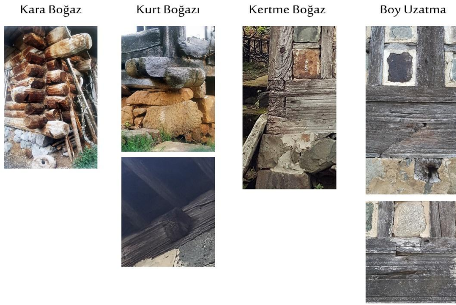
Şekil 2: Doğu Karadeniz Kırsal Mimarisinde Birleşim Detayları
