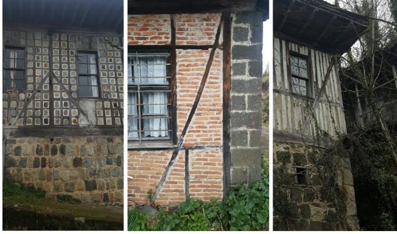
Şekil 6: Orta dikme, köşe dikme ve yançalma örnekleri
