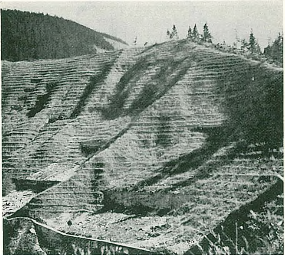
Resim 5. Göçüntülü bir yamaçın «köklenme kabiliyetinde dallarla desteklenmiş kordonlar» vasıtasıyla tahkim edilerek ekimle otlandırılmış durumu. Gallinabach (Vorarlberg), Avusturya.
