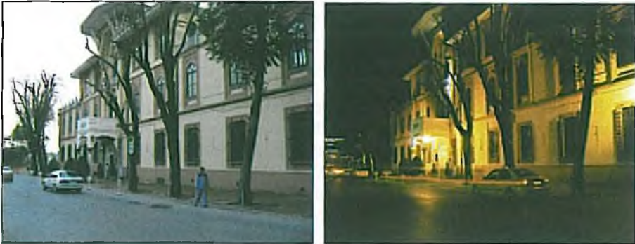
Şekil 4. Marmara Üniversitesi Rektörlüğü Binası gündüz ve gece durumu. Figure 4. Day and night view of Marmara University Rectorate Building.
