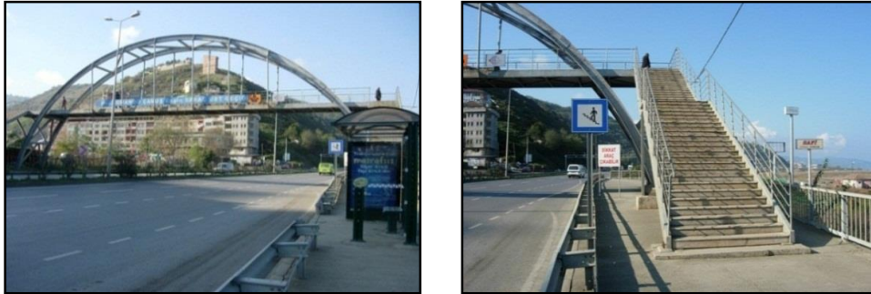
Şekil 11. Yaya üst geçidinden genel görünüş Figure 11. General view of pedestrian bridge
