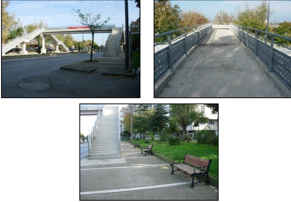
Şekil 19. Yaya üst geçidi ve çevresindeki oturma elamanlarına ait görünüş Figure 19. Pedestrian bridge and view of sitting elements in environment
