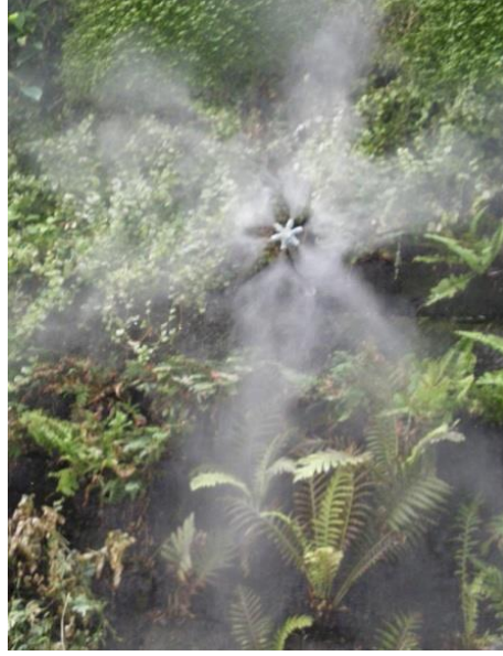
Şekil 3. Armağan AVM'de dikey bahçede sisleme yöntemi kullanılarak bitkilerin nem oranının optimum seviyelerde tutulması amaçlanmıştır (Orjinal, 2012). Figure 3. It is intended to kept at optimum levels of humidity of the plants by using fogging method in vertical garden Armağan AVM (Original, 2012).
