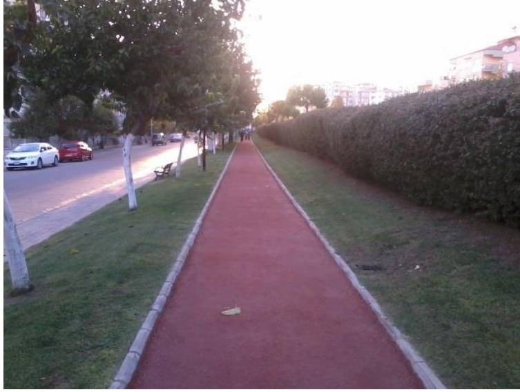
Şekil 3. Yeşil yol parkuru 2. Etap Figure 3. Greenway trail 2 nd stage
